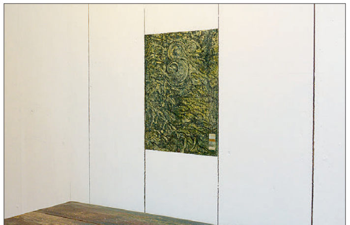
Unlängst wurde ein Stück Wandmalerei freigelegt, das demnächst komplett restauriert werden soll.
