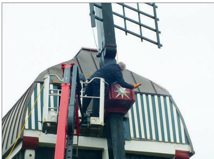
Mühlenbauer Diedrich Schlachter hat alle Arbeiten aus dem Korb eines Teleskopsteigers heraus geleitet.
