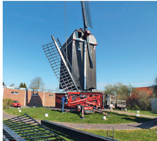
An Gründonnerstag, 9. April, wurden die neuen Flügel aufwendig montiert.
