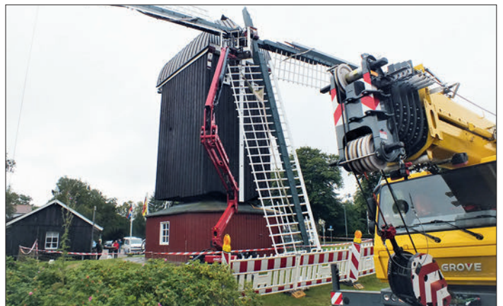
Am 12. Juli 2019, fünf Tage nach dem Abbruch einer Flügelspitze, wurden die Flügel komplett demontiert.
