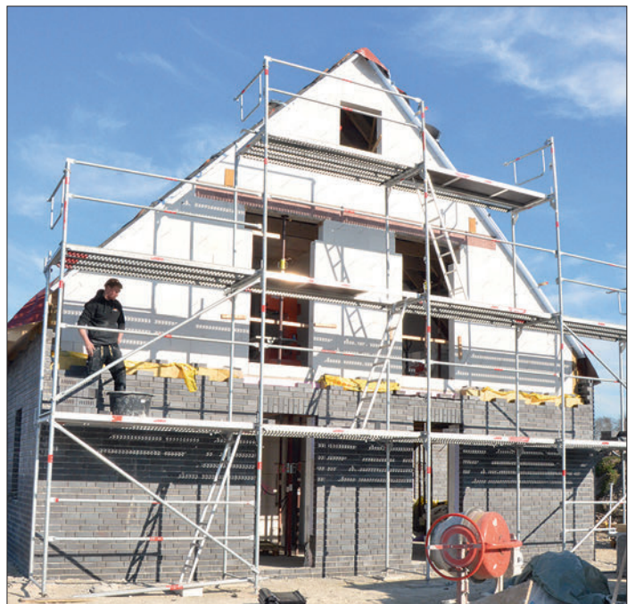
Rege Bautätigkeit herrscht zurzeit im Baugebiet „Up de Warf“.
